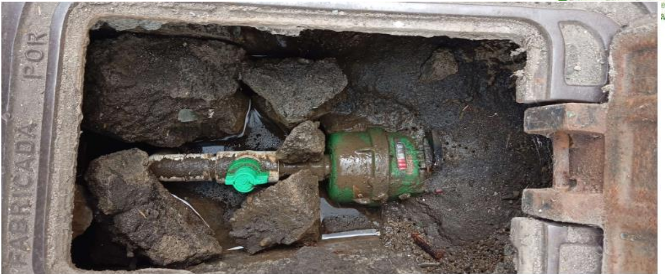
FOTOGRAFIA DEL MEDIDOR NUEVO, SIN ANCLAJE DE CONCRETO.
