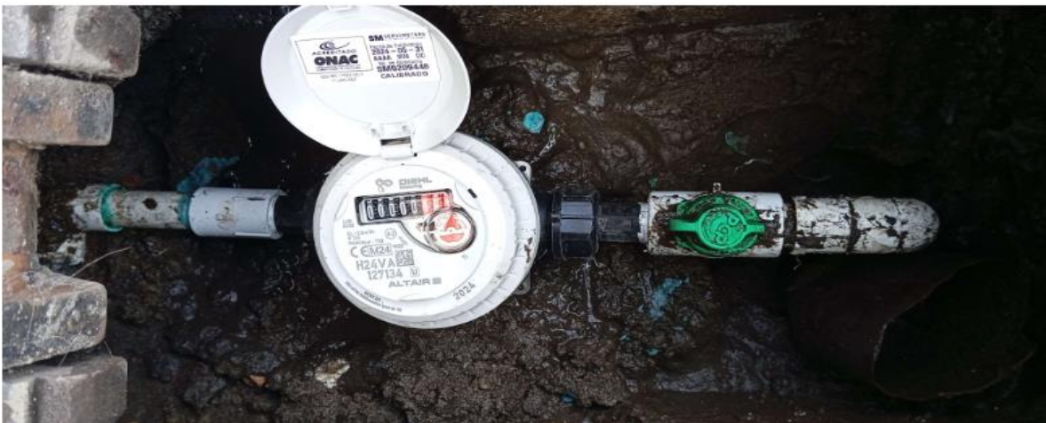
FOTOGRAFIA DEL MEDIDOR NUEVO, SIN ANCLAJE DE CONCRETO.
