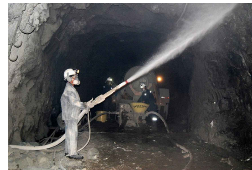
Detalle revestimiento de túneles Fuente: terraforte
