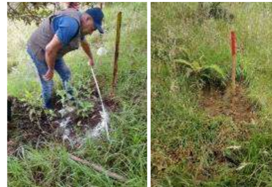
Contrato de obra 024-2022 – Predio La Estrella
