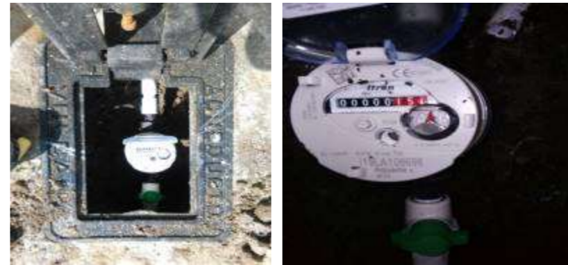
Instalación de medidores.
