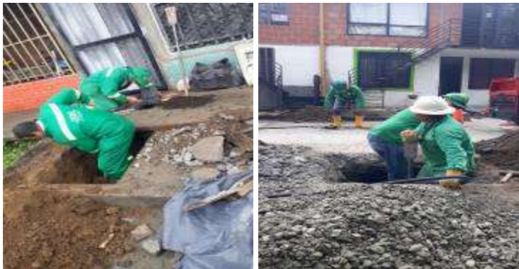
Construcción de acometidas.
