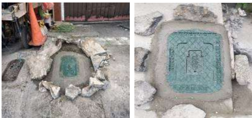
Instalación de Tapas y Cajas Tapa.
