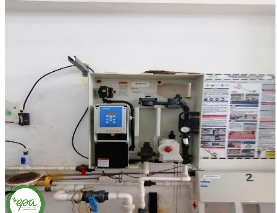
Planta de Tratamiento de Agua Potable -PTAP Regivit
