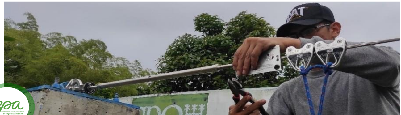
Bocatoma EPA ESP (Vereda El Agrado - Sector Boquía - Salento) - Planta de Tratamiento de Agua Potable - Regivit.
