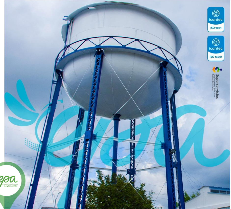
Planta de Tratamiento de Agua Potable - Regjvit
