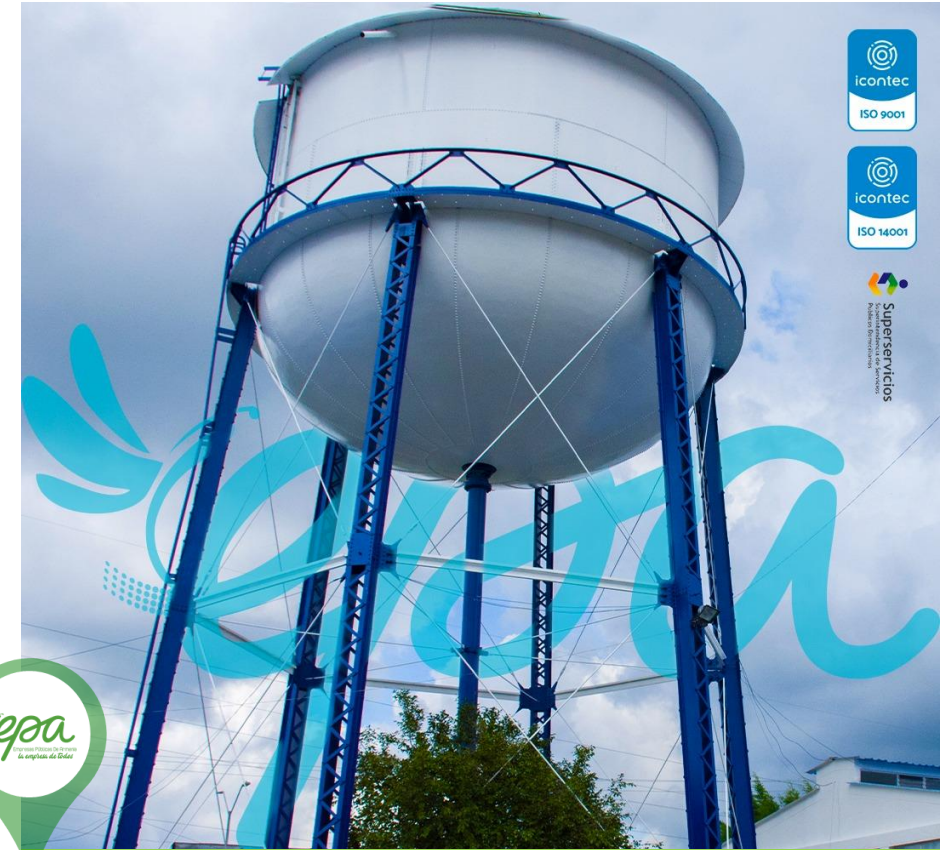
Planta de Tratamiento de Agua Potable - Regivit
