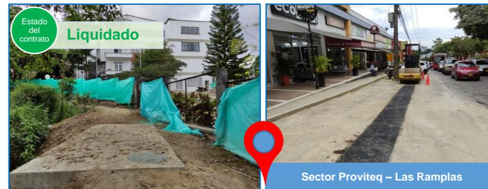
En este contrato se construyeron 93,97 metros lineales de tubería desde la cámara 51 de la Universidad del Quindío hasta la cámara 8 del colector Aldana, eliminando el punto de vertimiento DHA-08, el cual corresponde a una descarga de la Universidad del Quindío zona norte, bloque de ingeniería. A su vez también se instalaron 54,59 metros de tubería para **eliminar el vertimiento** de los supermercados Colsubsidio y Justo y Bueno, para un total de 148,56 metros de tubería instalada.
