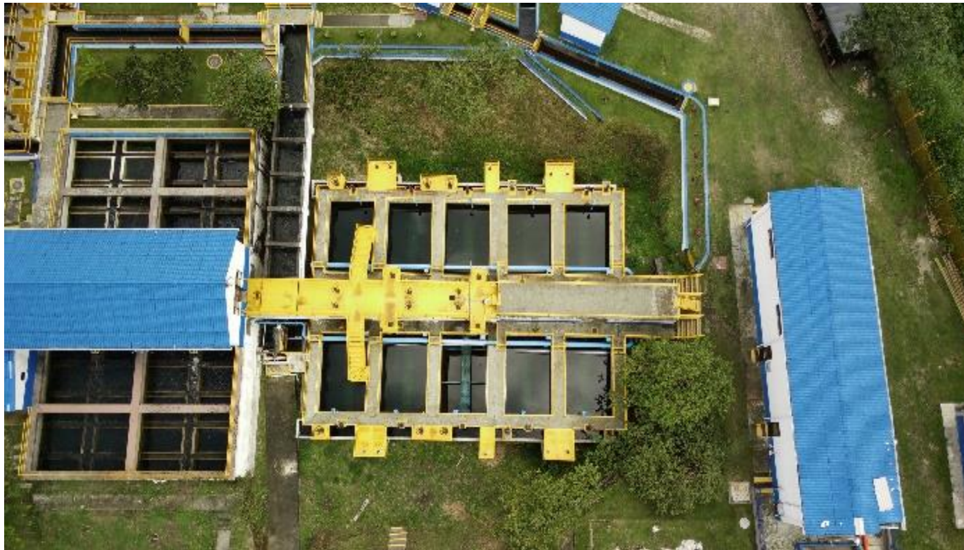
Ubicación: Planta de Tratamiento de Agua Potable - Regivit
