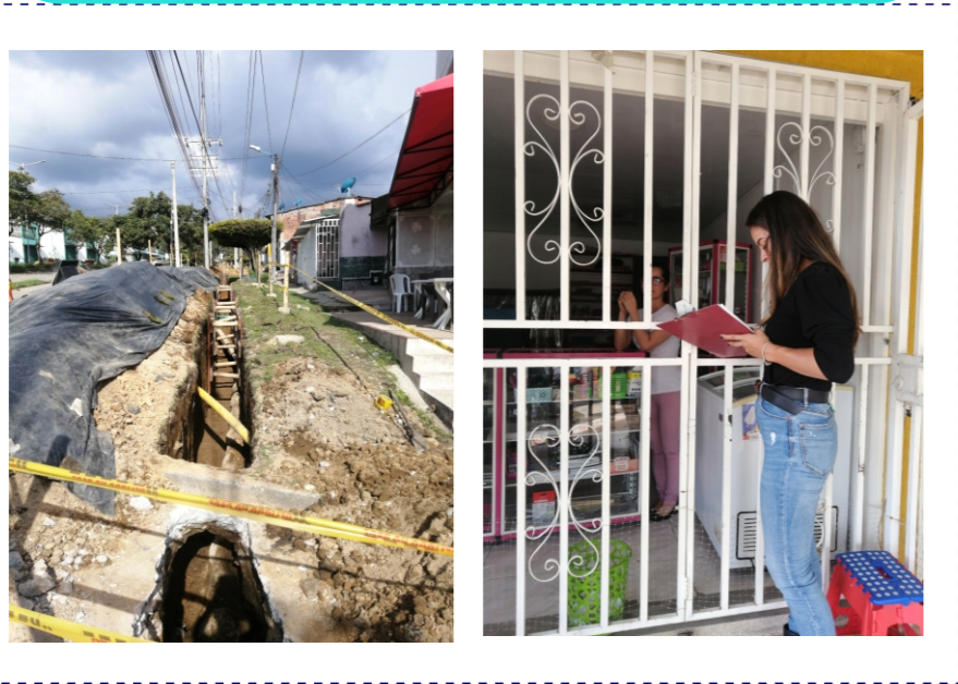
Noviembre 8 Visita Obra Barrio Arrayanes
