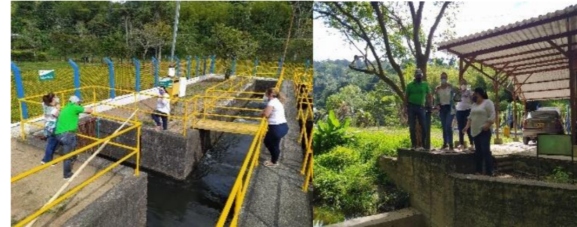
Registro fotográfico: Auditoría de Gestión Captación y Tratamiento 2021 (Bocatoma)
