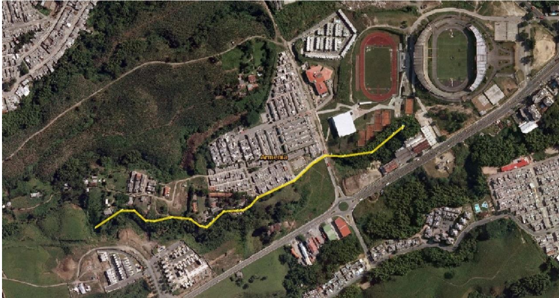
Ilustración 7 Foto aérea sector del colector Santa Ana
