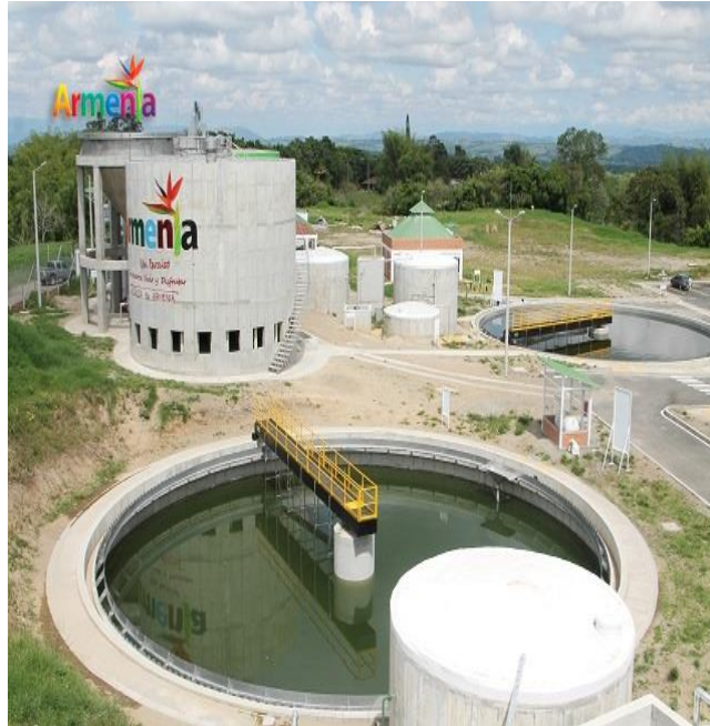
Foto 1 PTAR La Marina
