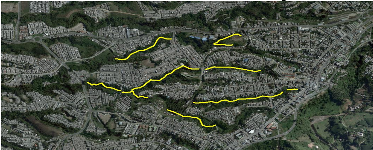
Ilustración 17 Foto aérea sector del colector afluente Yeguas
