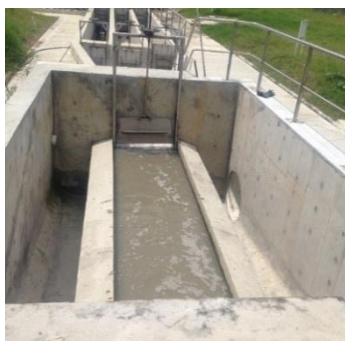
CANAL DE APROXIMACION
