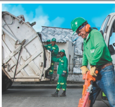
EPA cuenta con un plan de contingencia y emergencia para la prestación del servicio de aseo
